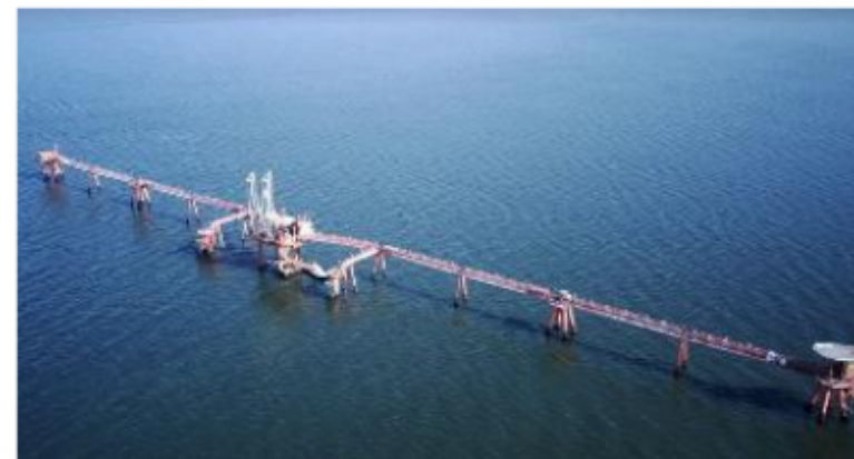
La piattaforma di Petra, qui si ormeggerà la nave rigassificatrice a 8,5 km dalla costa
